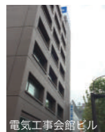
電気工事会館ビル
